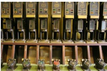
**Posta pneumatica:** tecnica sviluppata nel corso del XIX sec è stata spesso utilizzata per trasmettere plichi o piccoli oggetti tra uffici dello stesso fabbricato. Sono state anche sviluppate reti molto estese (50 km) e progettate per il recapito di pacchi pesanti. Ancora in uso per specifiche esigenze (banche, ospedali ..). Il plico può viaggiare a velocità di 10 m/sec.
